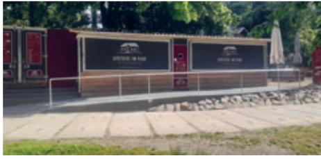
qualitätsgerechte Umsetzung bedanken. Die Arbeiten umfassten die Herstellung einer Rampe mit zwei Steigungsstrecken und einem Ruhepodest auf einer Länge von ca. 14 m sowie die Errichtung eines Handlaufes mit Fußabweiser. Der Kostenrahmen von 8.000 Euro konnte auch eingehalten werden, so dass jetzt zu hoffen bleibt, dass das Wetter wieder
