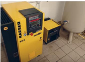
Vor wenigen Tagen gab es eine Neuanschaffung bei der Freiwilligen Feuerwehr Hainichen. Es handelt sich um ein neuen Schraubenkompressor. Diese Geräte werden in der Regel dann eingesetzt, wenn große Mengen Druckluft benötigt werden.
