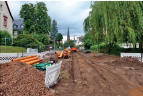
eine neue Bitumenfahrbahn, bestehend aus Trag- und Deckschicht, einzubauen ist, erfolgt im Bereich vom ehemaligen Bauhof bis zum Bauende an der Autowaschanlage ein grundhafter Ausbau. Hier waren im Altbestand zahlreiche Tragfähigkeitsschäden festzustellen.
