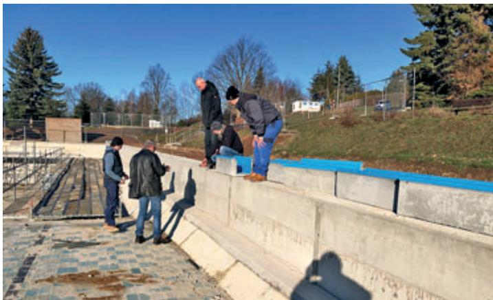
Das noch im Becken befindliche Gerüst soll in den nächsten 2 Wochen zurück gebaut werden. Dann können die Rohre mit den integrierten Düsen verlegt werden. Während das alte Bassin nur eine Frischwasserzufuhr (nahe beim Kinderbecken) hatte, werden im neuen Becken großflächig Düsen für die Versorgung mit Frischwasser angebracht. Für die anschließende Betonierung sollten dann Temperaturen von nicht unter 10 Grad vorherrschen.
