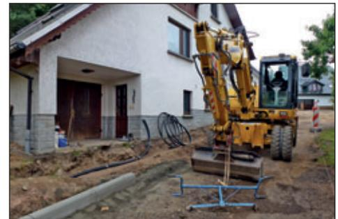
Im Zuge der Bauarbeiten werden auch Leerrohre bzw. Glasfaserkabel für den Breitbandausbau verlegt. Leider stellte sich gleich zu Beginn der Maßnahme heraus, dass der flach verlegte Rohrdurchlass am Beginn der Ausbaustrecke stark reparaturbedürftig ist. Auf Grund des baulichen Zustandes ist hier nur die Verlegung neuer Stahlbetonrohre statt einer weiteren Reparatur sinnvoll. Dadurch entstehen Mehrkosten von ca. 4.900,00 €. Die Bauarbeiten werden bis spätestens 28. August 2020 abgeschlossen sein.
