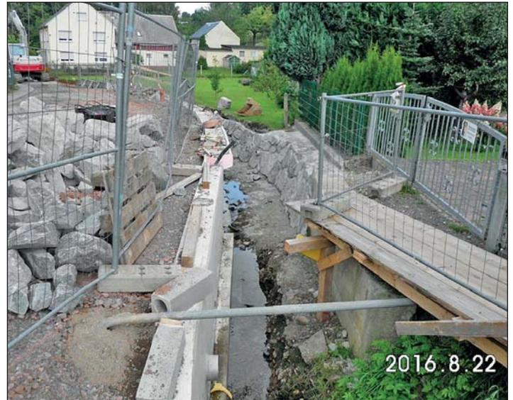
Derzeit ist der Ersatzneubau einer Stützwand in Riechberg in Arbeit. Anstelle der bisherigen Mauer entsteht eine Stahlbetonstützmauer. Die Fahrbahn wird in diesem Abschnitt ebenfalls erneuert.
